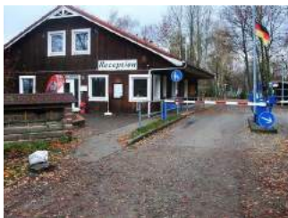
Empfangsgebäude mit Rezeption Bergwitzsee Resort
