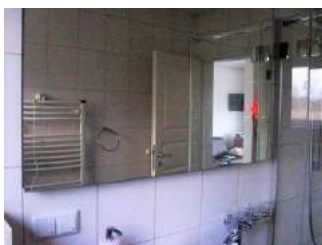
Der Spiegel ist nur im Stehen einsehbar. Die Tür schlägt nach innen auf.
