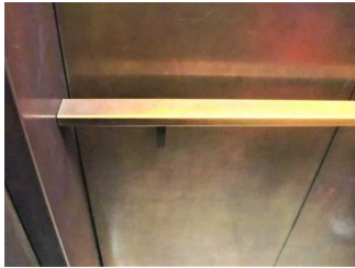
Detail des Handlaufes. Die Gestaltung des Handlaufes entspricht den Handläufen im sanierten/ rekonstruierten Schloss.
