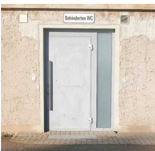
Pflasterung vor der WC-Tür
