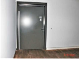
2. OG Neubau: Tür vom Rundgang zum Aufzug
