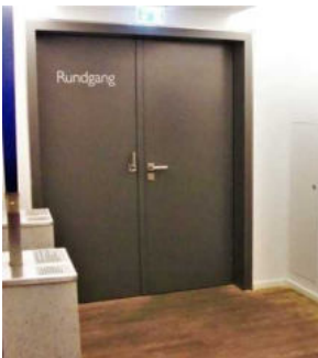
Eine der wenigen Türen, die von Besuchern geöffnet werden muss (Brandschutztür). Blick auf die Tür von Ausstellungsraum Melanchthonhaus aus
