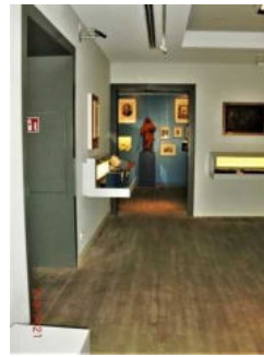
Durchgang vom Raum "Melancthons Familie" in den Raum "Studier- und Sterbezimmer". Lichte Breite: 79 cm; Schwelle im Raum "Melancthons Familie" Höhe: 8 cm; Schwelle im Raum "Studier- und Sterbezimmer" Höhe: 8 cm.
