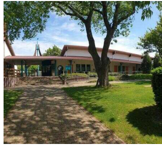
Blick auf Rampe und Treppe
