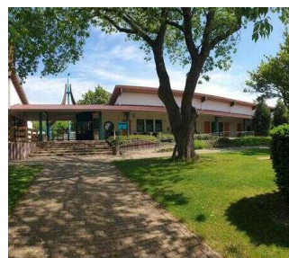
Blick auf Rampe und Treppe
