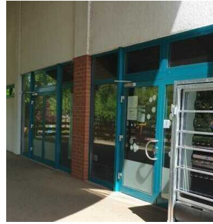
Zugang über die Terrasse
