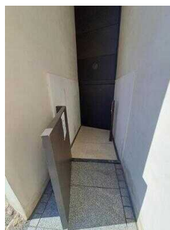
Oberer Hubplattformlift am Eingang
