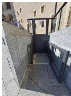
Der Hublift erreichbar auf der Gehwegebene. Die untere Zugangstür zum Hublift steht offen. Rechts im Bild ist die entsprechende Bedienstele zu sehen.
