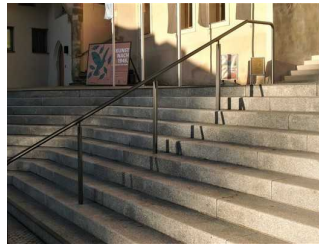
Treppe auf der Freifläche
