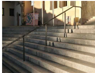
Treppe auf der Freifläche
